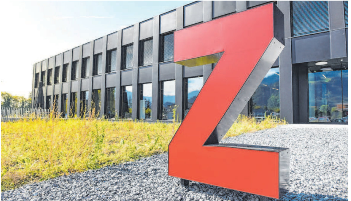
Von Beginn an war wichtig, dass das neue Gebäude von Z-Werkzeugbau die Unternehmenskultur unterstützt.
