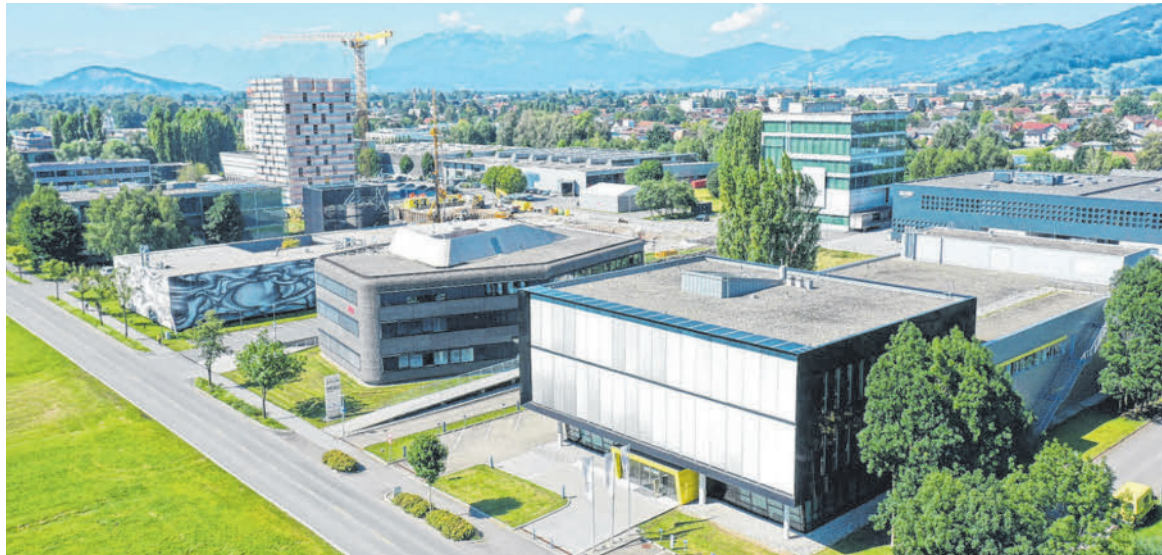
Im Millennium Park in Lustenau sind mit dem neuen Businesshotel und einem multifunktionalen Betriebsstandort gerade zwei Großprojekte am Entstehen.
