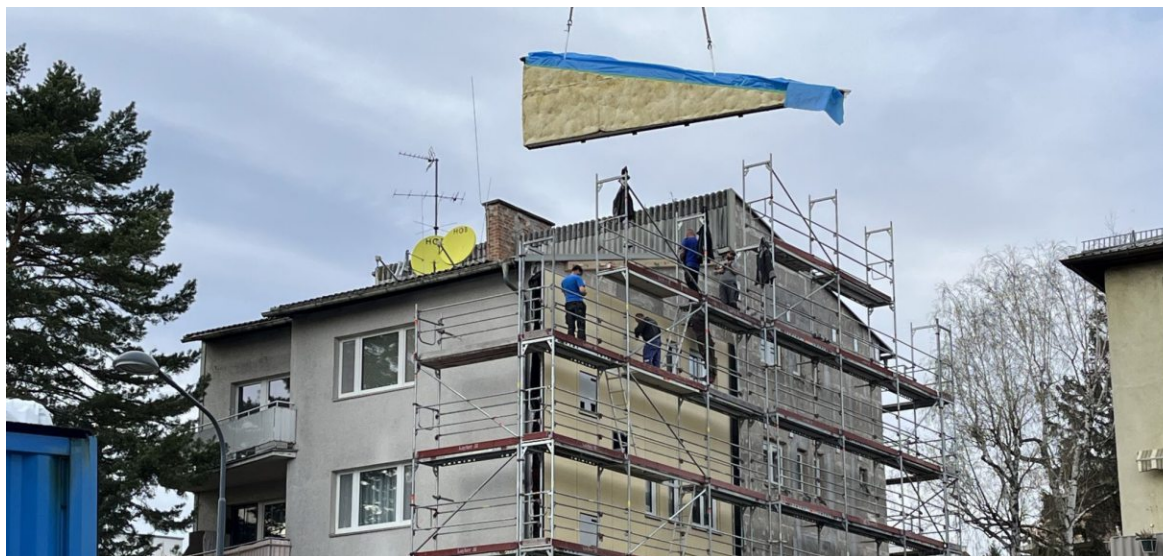
Vorgefertigte Fassadenelemente der Firma Kulmer Holzbau werden in einem Sanierungsprojekt der Sozialbau AG eingebaut. FA/MICHEL
