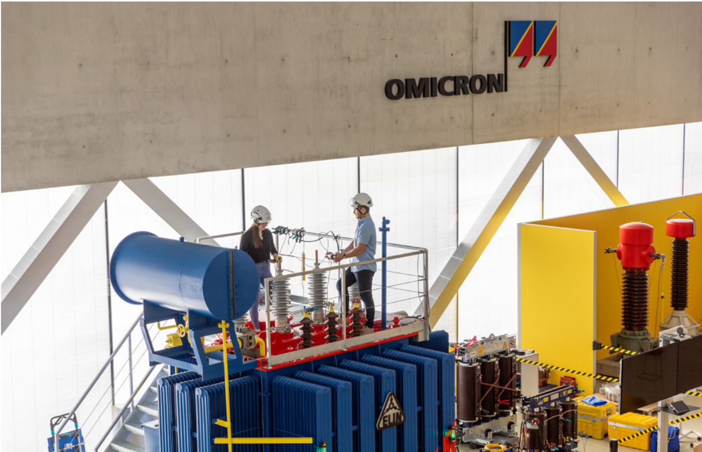
Die zur Firmengruppe OMICRON gehörende bz electronics GmbH investiert rund 25 Millionen Euro in die Errichtung ihres neuen Hauptsitzes im Rankweiler Betriebsgebiet Römergrund. Die drei bisherigen Standorte in Vorarlberg werden dort zusammengezogen. (c) Alexandra Folie, WISTO
