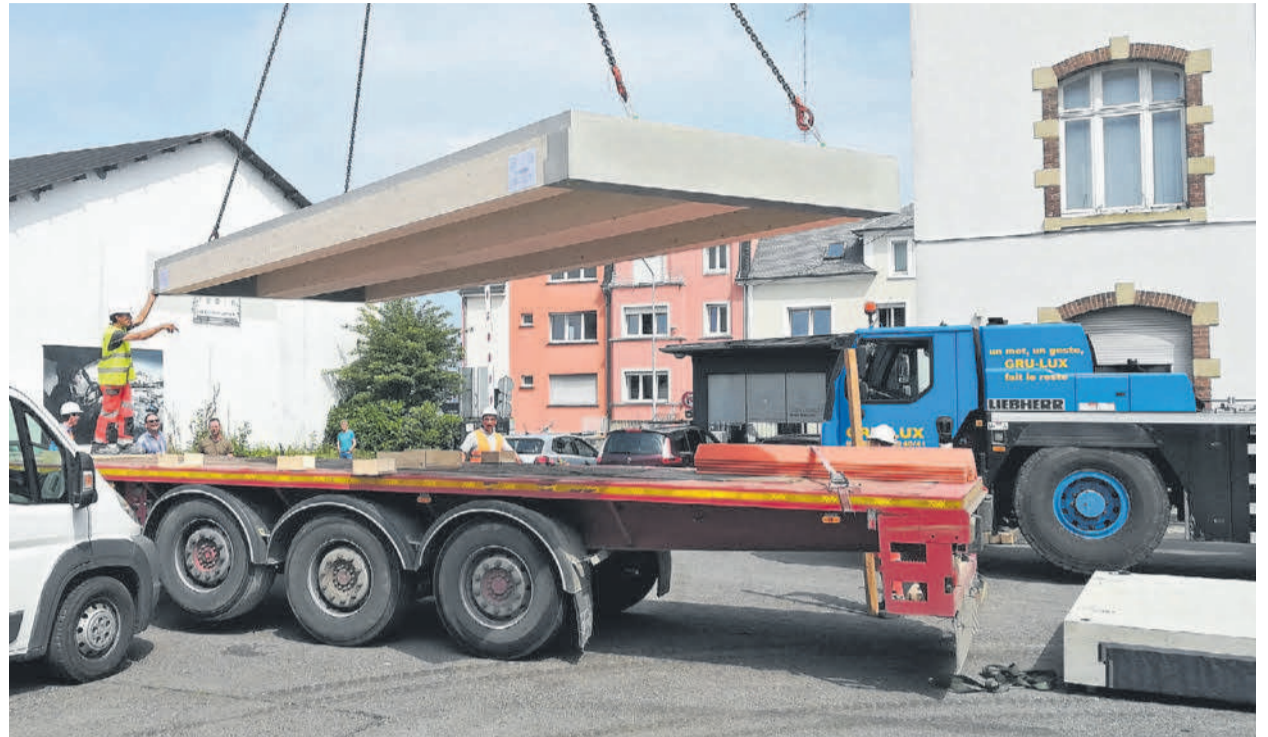
Cree ist Impuls- und Ideengeber in zwei „Horizon 2020“-Projekten und europaweit auf Expansionskurs. Das Unternehmen produziert ressourcenschonende Holz-Beton-Verbundelemente (Bild) auch in Luxemburg. (C) CREE
