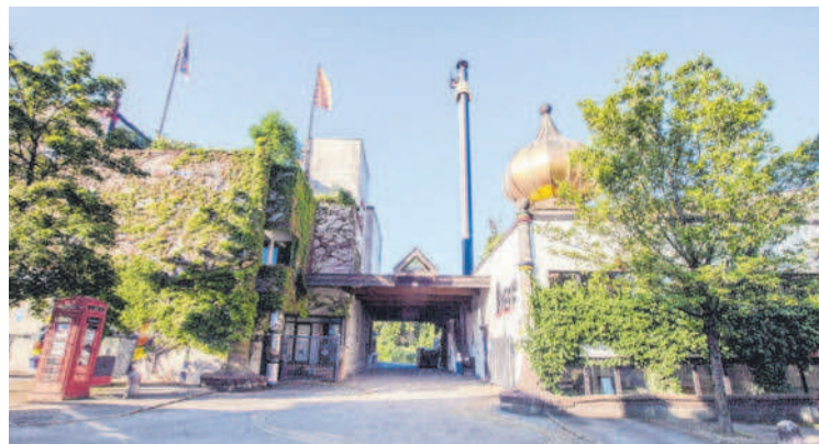
Das von Friedensreich Hundertwasser gestaltete Rueff-Gebäude.
