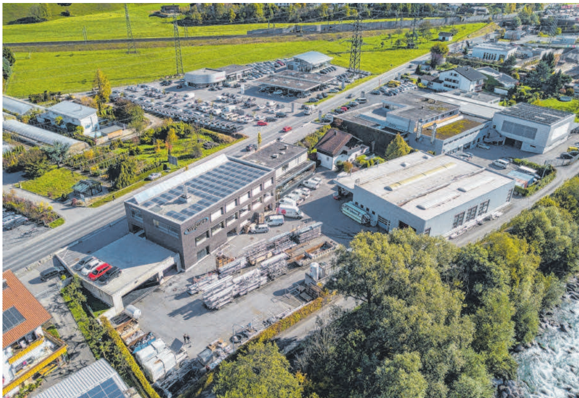
Wagner - hochmoderner Haustechnikbetrieb ist innovativer Anlagenbauer und industrialisiert die Rohrvorfertigung.
